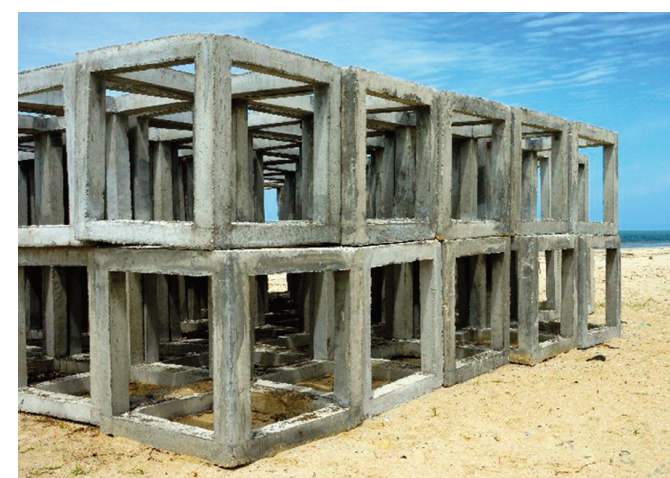
Barriere artificiali costituite da strutture modulari compatibili
